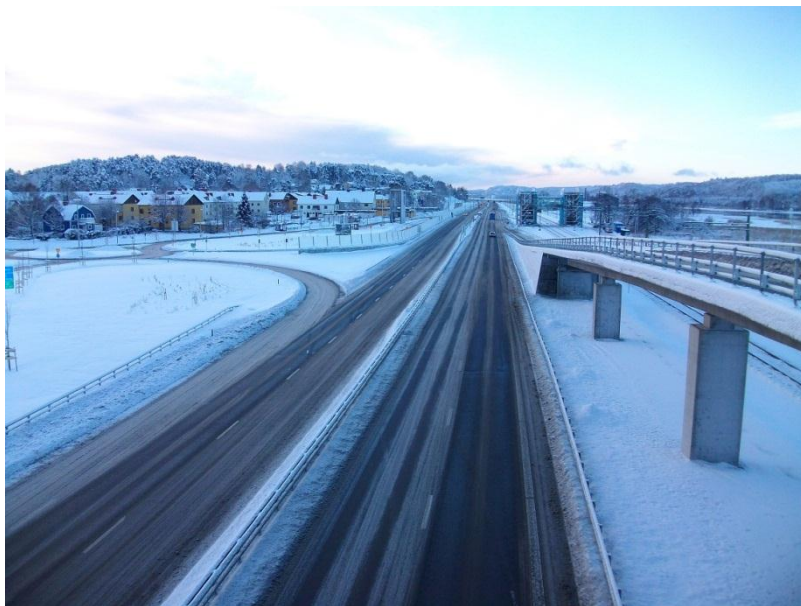
Figur 7 BanaVäg i Väst ombyggnation av E45, Foto Bojan Sevic NCC
